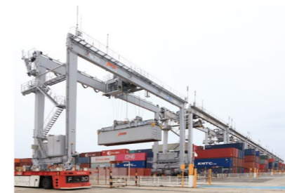
遠隔操作RTG
