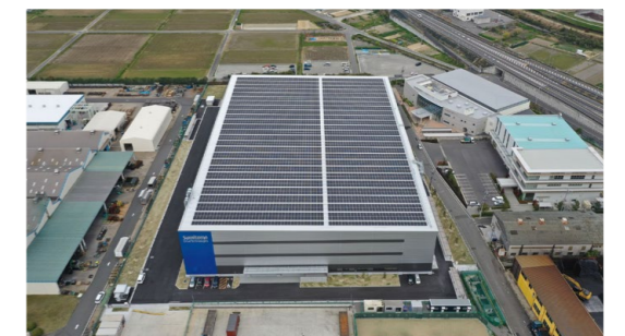
PTC第2工場の太陽光パネルの設置状況
