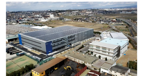
PTC第2工場全景
