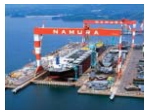
ゴライアスクレーン
