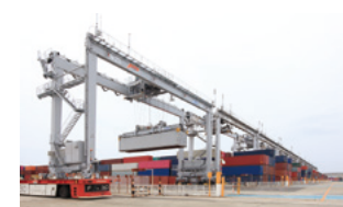
遠隔操作RTG
