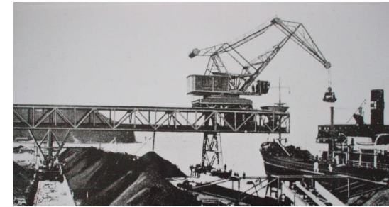
昭和11年納入 水平引き込み式クレーン
