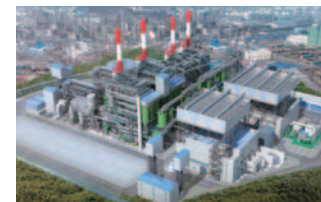
バイオマス発電設備
