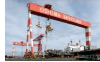
ゴライアスクレーン
